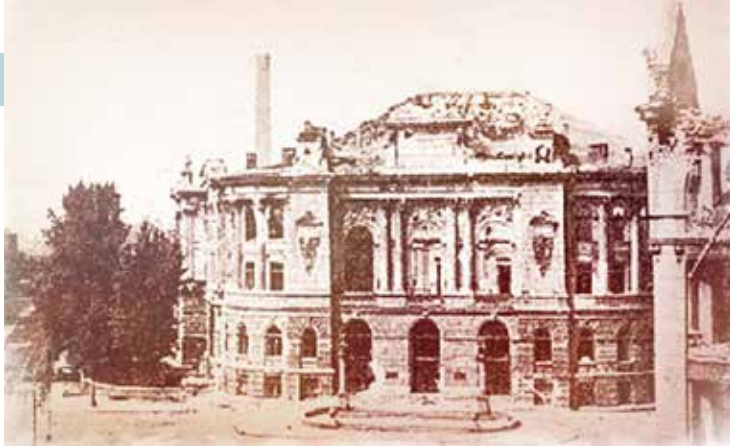
Zniszczony Gmach Główny Politechniki Warszawskiej – 18 sierpnia 1944 r.
