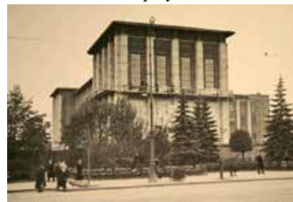
Budynek przy Alejach Jerozolimskich
