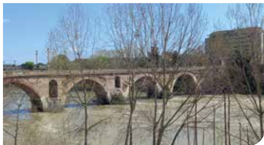
Most Mulwijski – trwale zapisany w historii Chrześcijaństwa za sprawą pamiętnej bitwy z 312 r. n.e. Obecny most – mimo modyfikacji – pozostaje w dużym stopniu zabytkiem autentycznym (w stanie nienaruszonym zachowały się cztery przęsła).
