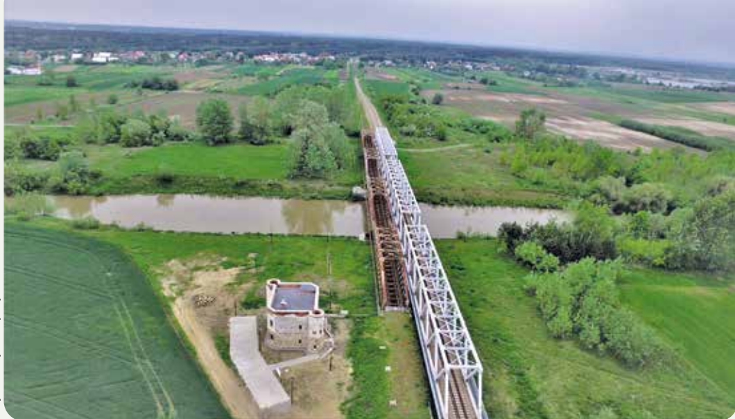
Współczesny widok w kierunku wschodnim na strażnicę kolejową i most nad rzeką Wisłok. W 2015 roku, obok starej, pamiętającej czasy Austro-Węgier konstrukcji, powstał nowy, liczący ponad 200 metrów obiekt.
