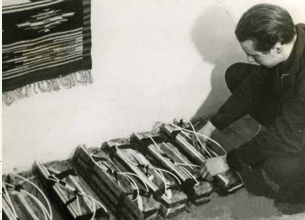
Wykonane ładunki przygotowane do użycia w akcji wysadzenia mostu. Fotografię wykonał reporter BiP Kazimierz Józefowicz „Kalif”. Chodaczów, 5.04.1944 r.
