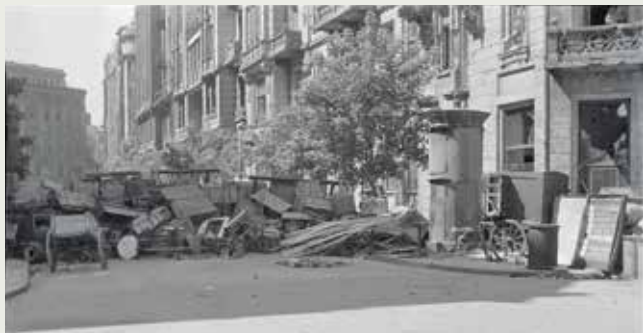
Barykada przy wylocie ul. Boduena na ul. Szpitalną. Po prawej obok transformatora kioskowego widoczny chłopic. W tle po lewej budynek Powszechnego Banku Związkowego przy ul. Zgoda 11.
