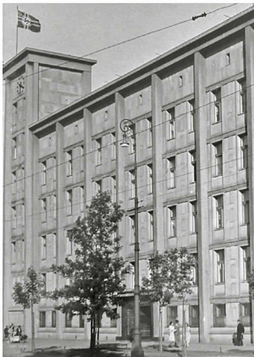
Flaga hitlerowska na budynku WIG (14.10.1939 r.) przy Al. Jerozolimskich 97, wzniesionym w latach 1933–1934, wg. projektu Antoniego Dygata
